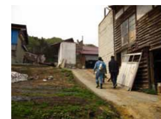
被害を受けた牛舎
